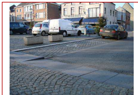
Emplacement réservé et raccord avec le trottoir
